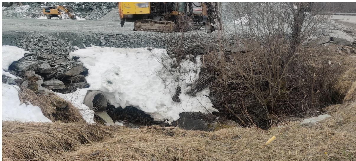
Figur 6 Foto 15.04.23 av bekk som kommer ut stikkrenne under adkomstvei, før den renner i stikkrenne under fylkesveien mot høyre.
